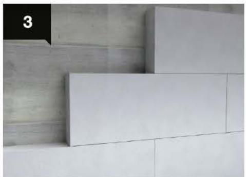
Οι θερμομονωτικές πλάκες (EPS, XPS) επικολλούνται σε οριζόντιες επάλληλες στρώσεις, από κάτω προς τα πάνω, σε διάταξη διασταυρούμενων αρμών, ώστε να αποφύγουμε τον κίνδυνο ρηγματώσεων του τελικού σοβά.
