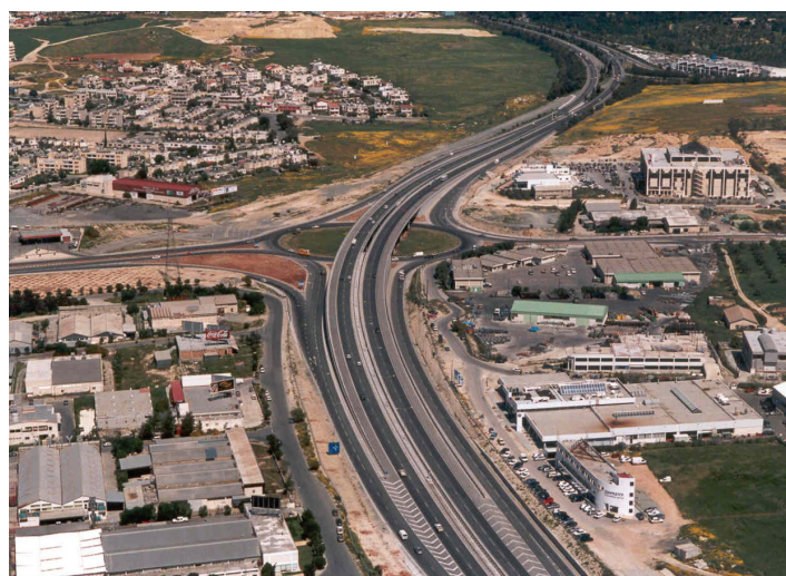
Κατά την κατασκευή του ανισόπεδου κυκλικού κόμβου Στροβόλου η Medcon χρησιμοποίησε αρκετές καινοτόμες λύσεις.
